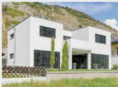
Einfamilienhaus in Niedergesteln
